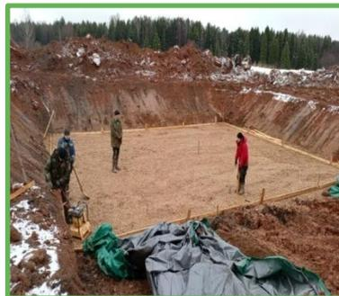
**Устройство противofiltrационной завесы и системы сбора фильтрата**
