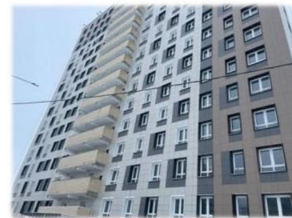
МКД по адресу: г. Киров, ул. Энтузиастов, д. 54
